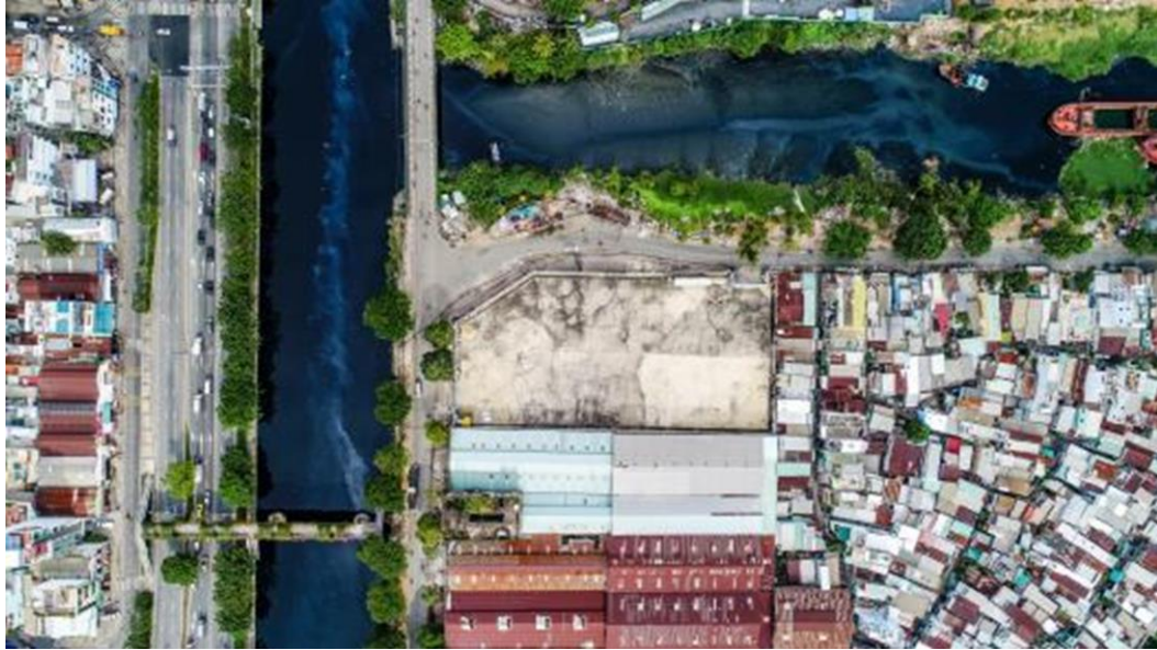
Toàn cảnh khu đất của dự án nhìn từ trên cao
